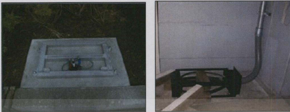
รูปที่ 3.17 การติดตั้งฐานรอง Charger
