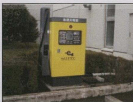
รูปที่ 3.10 การติดตั้ง Charger
