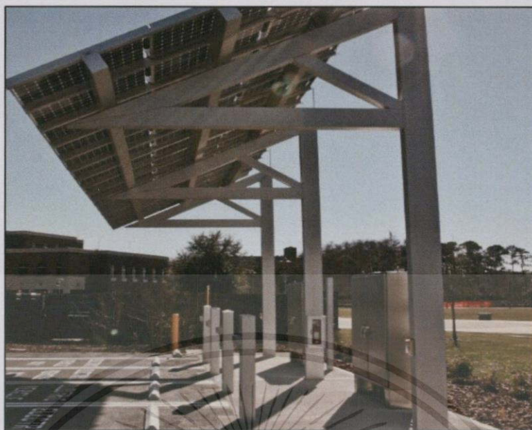
รูปที่ 3.29 การวางแผนโซลาร์เซลล์แบบ ไบ-เฟเชียล ( Bi-Facial )
