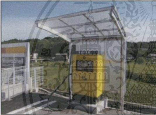
รูปที่ 3.15 รูปแบบการติดตั้งหลังคา ป้องกัน Charger
