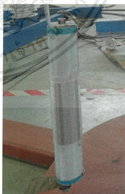
รูปที่ 3.25 ความต้านทานแม่เหล็ก ขนาด 42 \Omega
