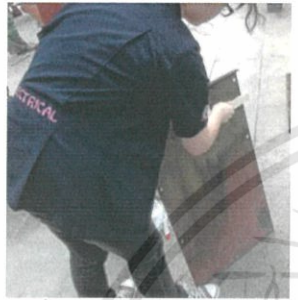
รูปที่ 49 ชัดสนิมเตรียมทาสีเคลือบ
