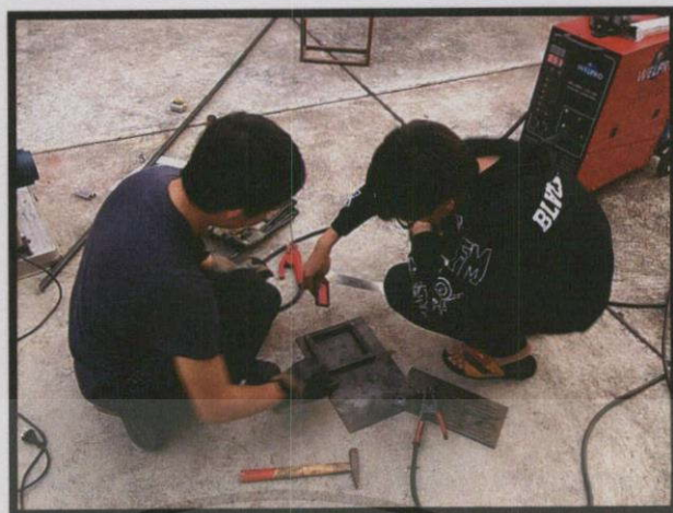
รูปที่ 3.2 แสดงภาพขั้นตอนการเชื่อมแท่งเหล็กเข้าด้วยกัน
