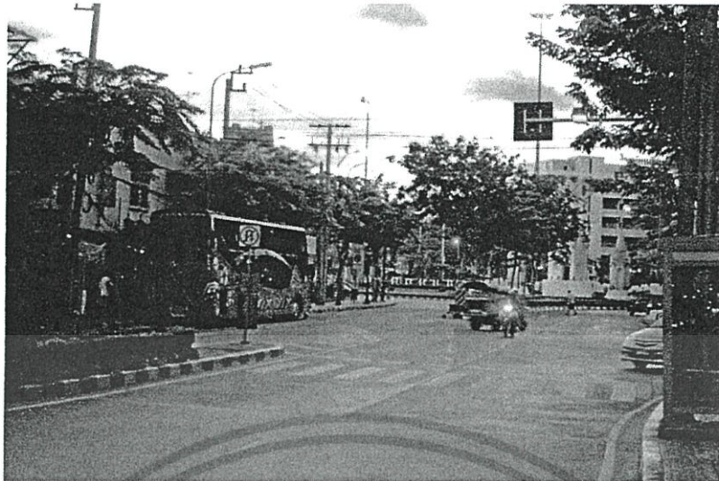
รูปที่ 6.8 ภาพแสดงถนนทางเข้าโครงการ
