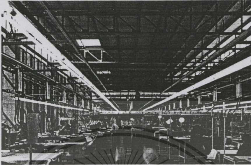
รูปภาพ 6-8 บริเวณของส่วนตัดเย็บที่ใช้โครงสร้างเหล็ก 2 มิติในการพาดช่วง
