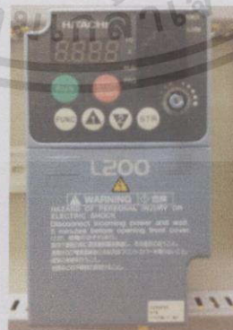
รูปที่ 2.9 อินเวอร์เตอร์ที่ใช้ในโครงการนี้ HITACHI รุ่น L200-005NFEF
