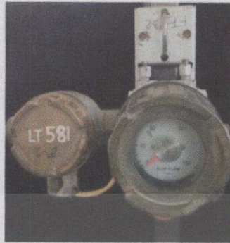
รูปที่ 3.10 Level Indicator Transmitter
