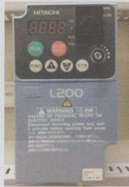
รูปที่ 3.13 อินเวอร์เตอร์ที่ติดตั้งในกระบวนการ
