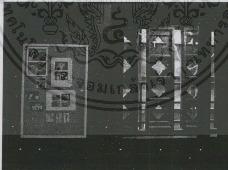
ภาพที่ 3.16 Façade ภายนอกอาคาร สามารถอำพรางพื้นที่ว่างคอมเพรสเซอร์แอร์ได้
