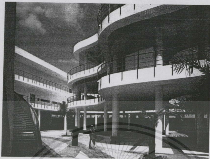
ภาพที่ 3.61 พื้นที่ภายในอาคาร
