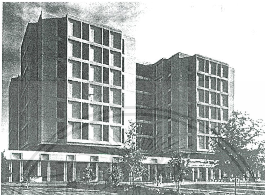
รูปที่ 7.13 แสดงอาคารตัวอย่างของการวางผังแบบ The radial square, a variation on the round
