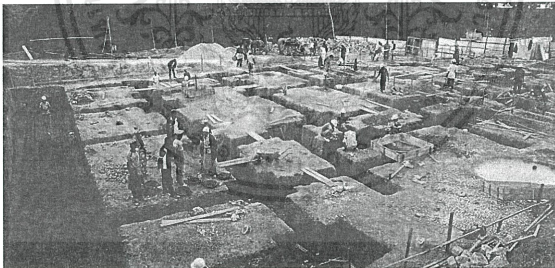
รูปที่ 5.24 แสดงการปรับปรุงสภาพที่ตั้งโครงการและการทำฐานราก
