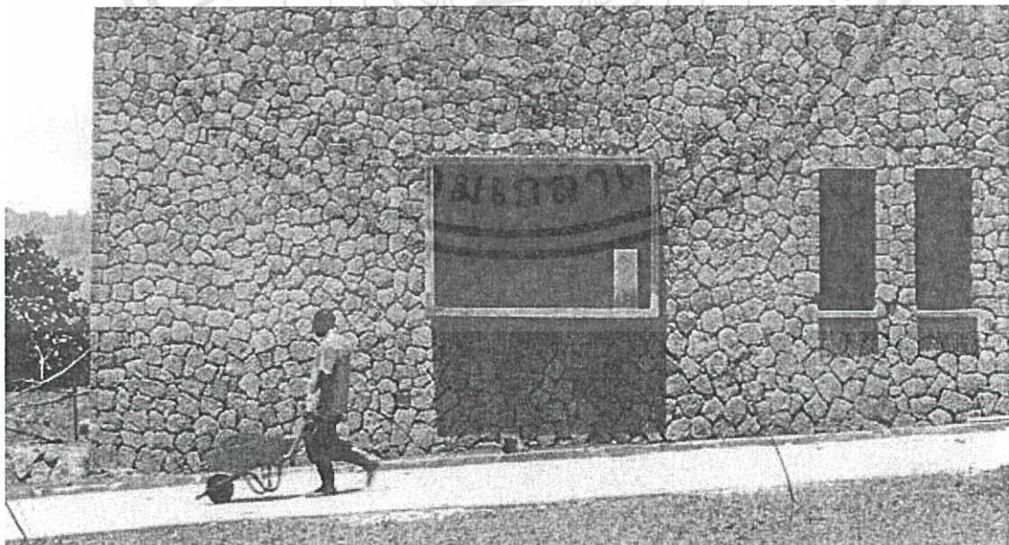
รูปที่ 5.27 แสดงการใช้วัสดุและเทคโนโลยีท้องถิ่นในการก่อสร้างอาคาร
