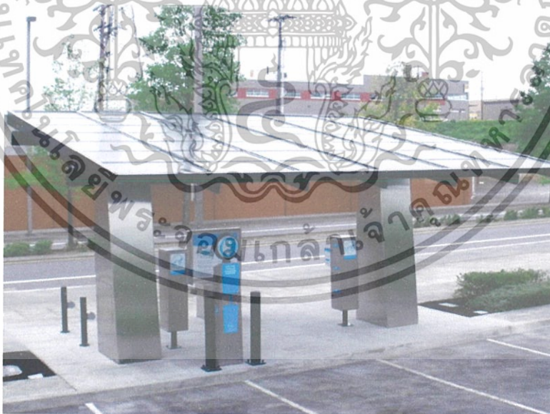
รูปที่ 1.1 หลังคาเซลล์แสงอาทิตย์ (Solar Cell) และเครื่องชาร์จแบตเตอรี่สำหรับจักรยานยนต์ไฟฟ้า
