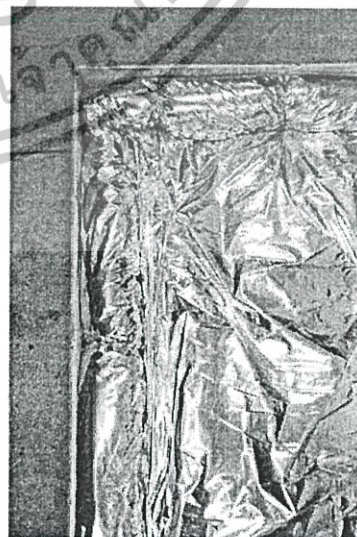
รูปที่ 3.3 แผ่นฉนวนกันความร้อนที่บุอยู่ภายในของแผงรับแสงอาทิตย์
