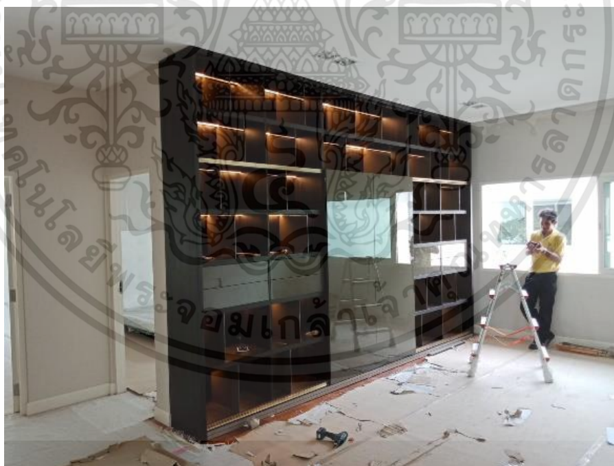
ภาพที่ ค.38 การติดตั้งเครื่องเรือนที่บ้านลูกค้า ที่มา : วรากร ช้อยอุบล
