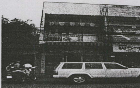
ส่วนบริเวณด้านหน้าอาคาร
