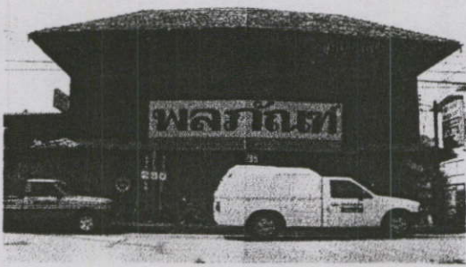
ส่วนบริเวณด้านหน้าอาคาร
