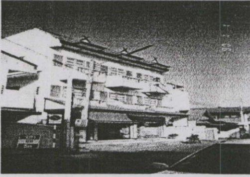
ลักษณะกายภาพภายนอกอาคาร
