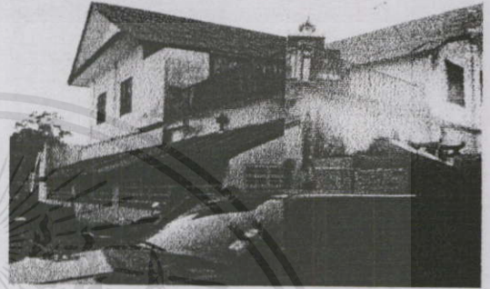
ส่วนบริเวณด้านหลังอาคาร
