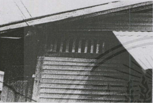
ส่วนบริเวณใต้หลังคาทำเป็นช่องระบายอากาศ
