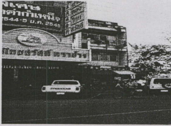
ส่วนบริเวณด้านหน้าอาคาร
