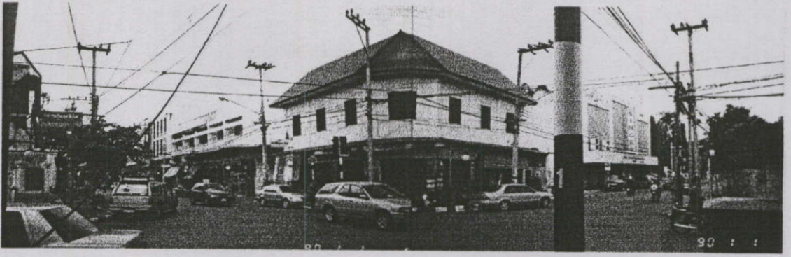
ส่วนบริเวณด้านหน้าอาคาร
