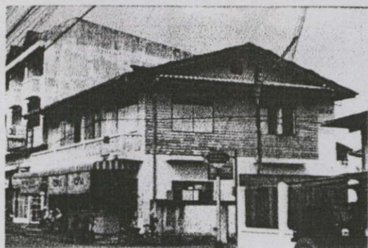
ส่วนบริเวณด้านข้างอาคาร
