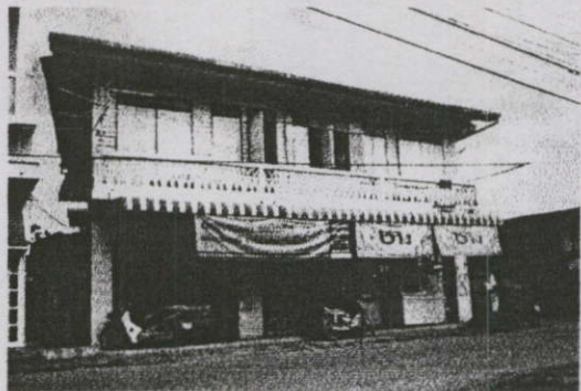
ส่วนบริเวณด้านหน้าอาคาร
