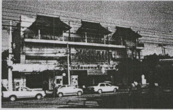
ลักษณะกายภาพภายนอกอาคาร
