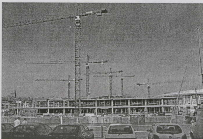
ภาพที่ 1.12 เทาว์เวอร์ เครน (Tower Crane)
