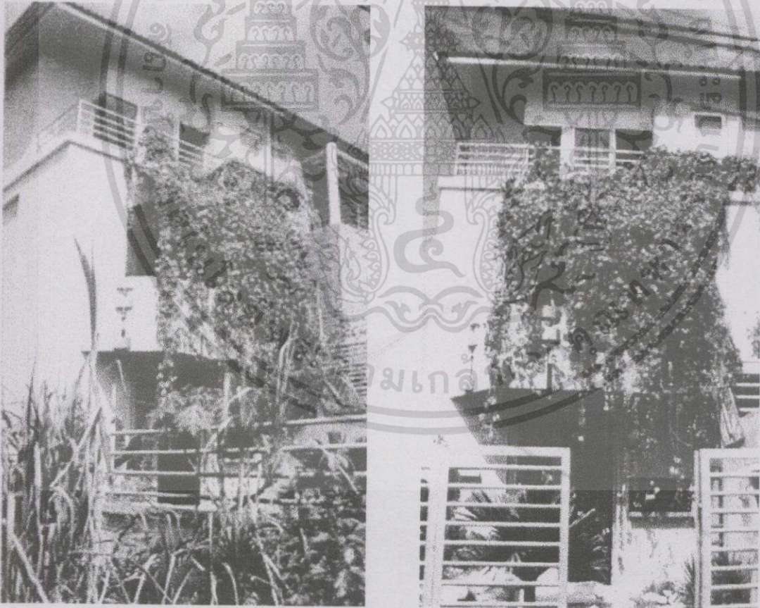
รูปที่ 7.12 อาคารตัวอย่างที่ใช้ทำการทดสอบประสิทธิภาพของการใช้แผงบังแดดไม้เลื้อยในแนวตั้ง บังเงาถึงและผนังอาคาร
