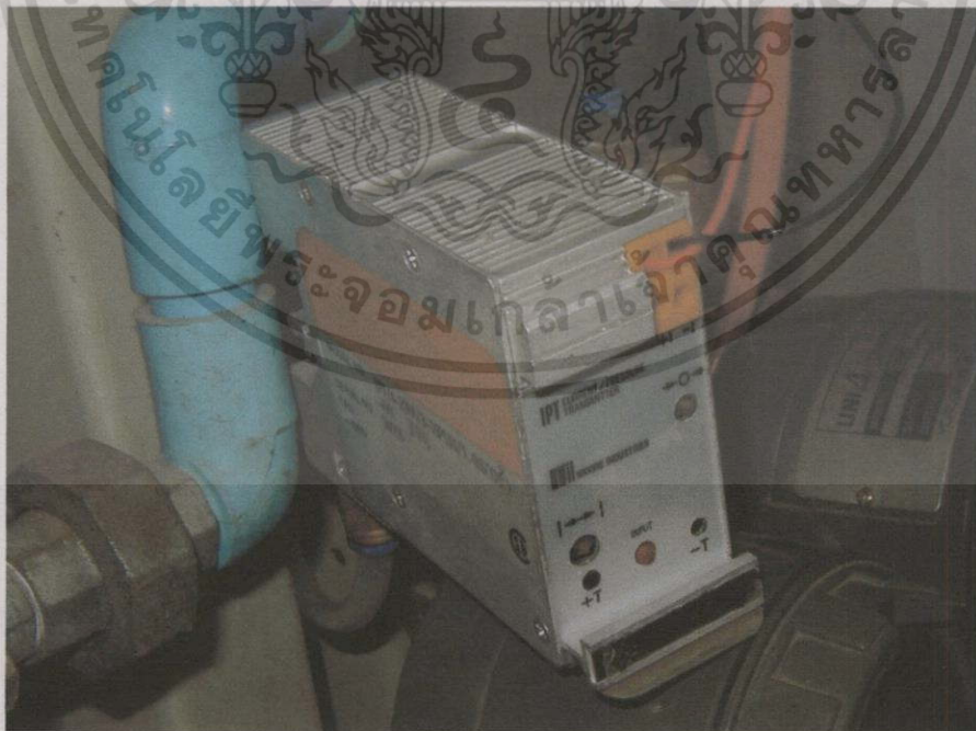
รูปที่ ค.7 แสดงตัวแปลงกระแสไฟฟ้าเป็นความดัน (I/P)
