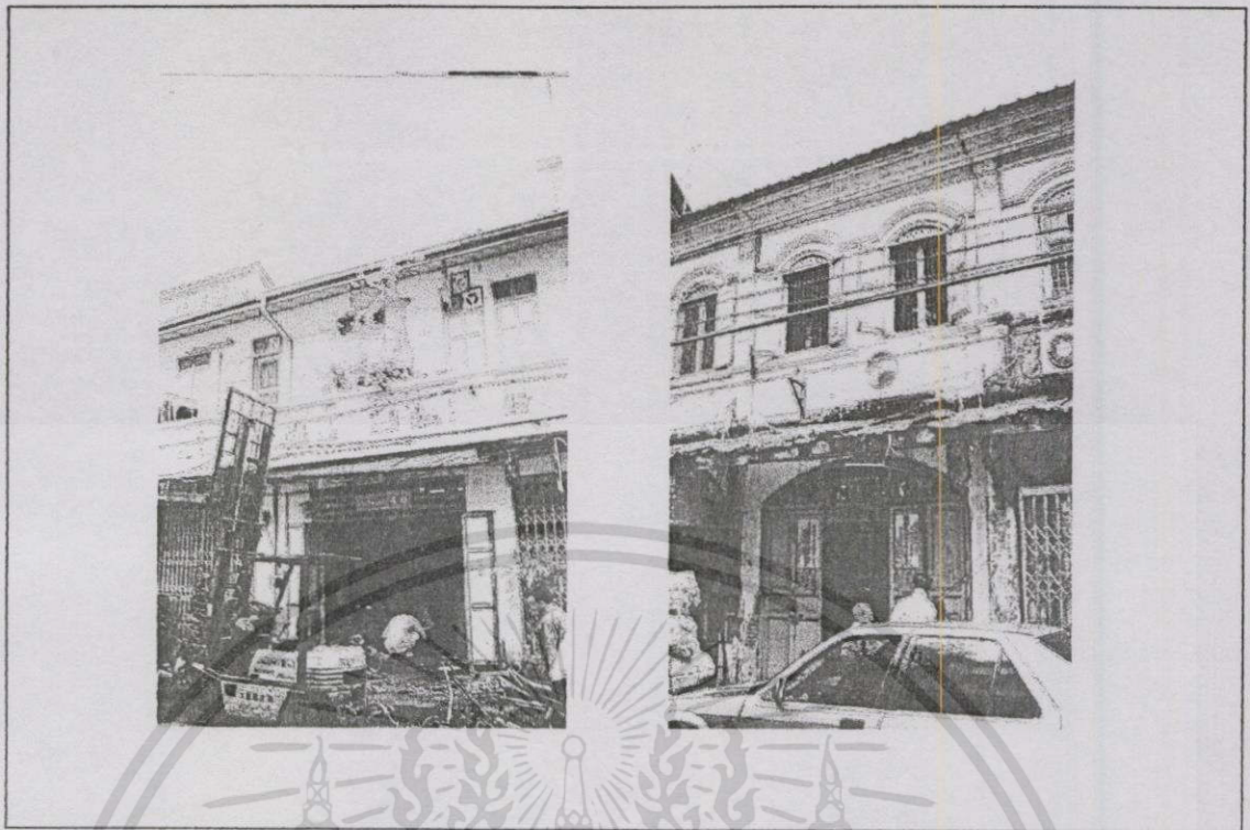
ภาพแสดงอาคารทางประวัติศาสตร์ในย่านค้าที่ซัดกับข้อกำหนด บริเวณเชียงใหม่ ที่มา : การสำรวจพื้นที่ ตุลาคม 2543
