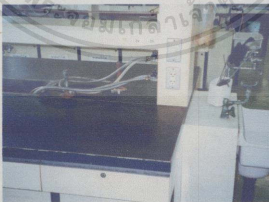
ภาพที่ 2.19 ท่อจ่ายแก๊สบนโต๊ะปฏิบัติการเคมีพื้นฐาน เป็นท่อสายอ่อนมีวาล์วควบคุมเปิด - ปิด แยกแต่ละท่อ
