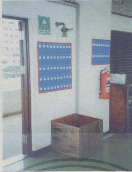
ภาพที่ 2.20 การติดตั้งตำแหน่งเครื่องดับเพลิงควรอยู่ใกล้ประตู ที่มา คณะวิทยาศาสตร์ สถาบันเทคโนโลยีพระจอมเกล้าเจ้าคุณทหาร ลาดกระบัง
