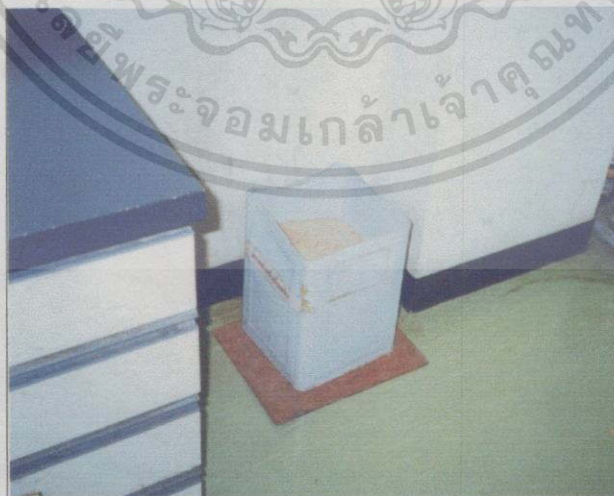
ภาพที่ 2.10 ถังทรายสำหรับดับเพลิง ในห้องปฏิบัติการเคมี ที่มา คณะวิทยาศาสตร์ สถาบันเทคโนโลยีพระจอมเกล้าเจ้าคุณทหารลาดกระบัง
