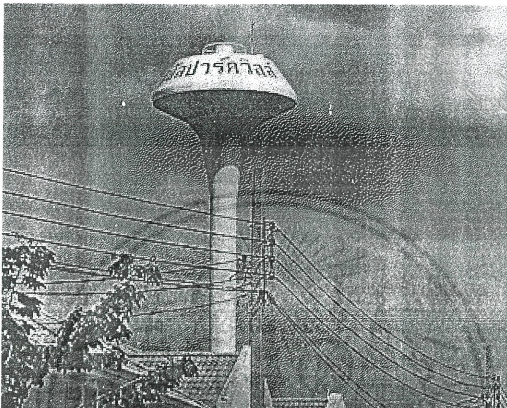
ภาพที่ 5.34 ภาพตัวอย่างระบบประปาบาดาล ภายในโครงการอสังหาริมทรัพย์
