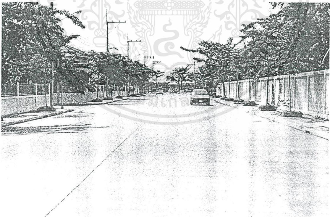
ภาพที่ ก - 36 ถนนสายสายรองในโครงการอสังหาริมทรัพย์ตัวอย่าง มีการจราจรแบบเดินรถสวน เอกสารนี้เป็นเอกสารทาง มี 4 ช่องทางการใช้งานเพื่อการศึกษาเท่านั้น ไม่อนุญาตให้นำไปใช้ประโยชน์ด้านการค้า ไม่ว่าจะกรณีใดๆทั้งสิ้น อีกทั้งห้ามมิให้ดัดแปลงเนื้อหา และต้องอ้างอิงถึงเจ้าของเอกสารทุกครั้งที่มีการนำไปใช้
