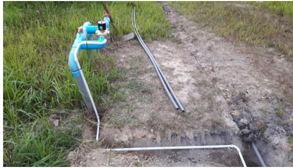
ภาพที่ ช-5 การติดตั้งสายไฟโซลีนอยด์วัลว์
