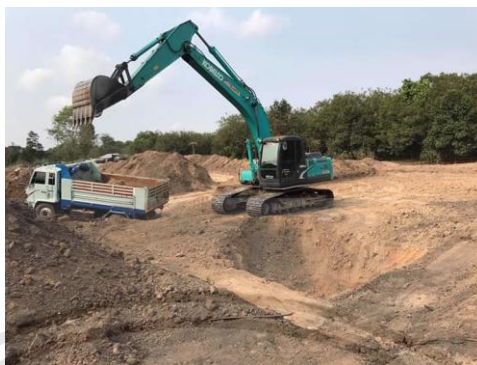
ภาพที่ ฌ-15 ขั้นตอนการวางแนวเพื่อขุดสระกักเก็บน้ำ
