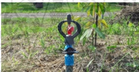
ภาพที่ 4.24 ระบบการให้น้ำแบบหัวจ่ายน้ำ
