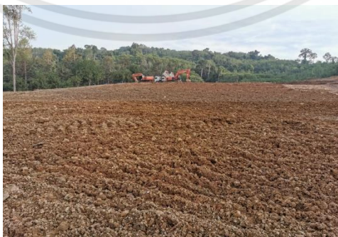
ภาพที่ ฅ-6 สภาพพื้นที่สวนหลังทำการปรับพื้นที่แล้ว
