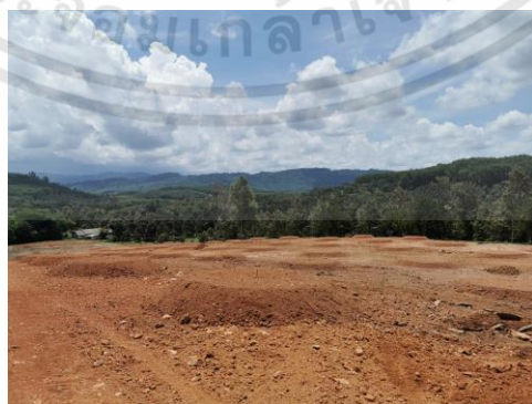
ภาพที่ ฅ-12 สภาพพื้นที่สวนพร้อมสำหรับการปลูกทุเรียนเหลือขั้นตอนการวางระบบน้ำภายในสวน
