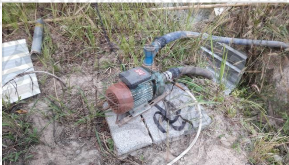
ภาพที่ ช-3 การติดตั้งมอเตอร์ไฟฟ้าต้นกำลังสำหรับสูบน้ำ
