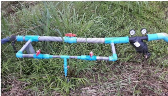
ภาพที่ ช-2 การติดตั้งอุปกรณ์ระบบน้ำ
