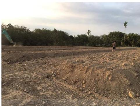
ภาพที่ ฅ-18 ทำการยกลอนลูกฟูกขนาดความสูง 50-60 ซม. กว้าง 4 เมตร
