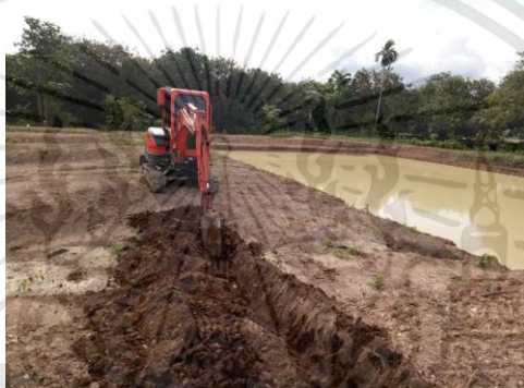
ภาพที่ ฅ-19 ใช้แบคโฮเล็กขุดร่องสำหรับการวางท่อประธานของระบบน้ำภายในสวน
