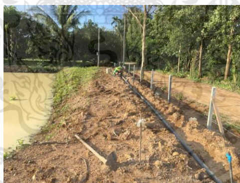
ภาพที่ ฅ-20 การขุดร่องสำหรับการวางท่อแขนงของระบบน้ำภายในสวน
