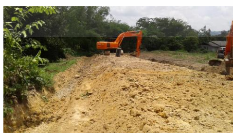
ภาพที่ ฅ-2 ขั้นตอนการวางแนวเพื่อขุดสระกักเก็บน้ำ
