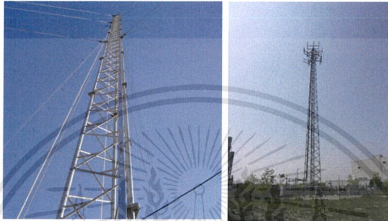
ภาพที่ 2.4 เสาส่งสัญญาณแบบ Guyed Mast Tower และแบบ Self Support Tower [11]
