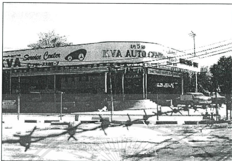
ภาพที่ 4.10 ภาพแสดงรูปด้านหน้าอาคารโชว์รูมบริษัท เควีเอ จำกัด
