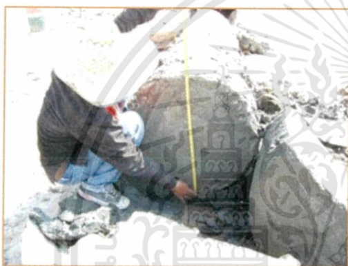
รูปที่ 2.46 วัดขนาดเส้นผ่านศูนย์กลางและพิจารณาความสม่ำเสมอของเนื้อดินซีเมนต์[2] ในกรณีที่เสาเข็มดินซีเมนต์มีขนาดใหญ่ (>1.0 m) หรือมีความลึกเกินกว่าปลอกเหล็กจะลง ไปได้ ให้ทำการทดสอบแบบ 4 Holes Coring โดยเจาะตามขอบของเสาเข็มดินซีเมนต์เพื่อ พิจารณา ความยาว และความสม่ำเสมอ หากเสาเข็มดินซีเมนต์มีขนาดใหญ่อาจเจาะ Coring มากกว่า 4 รู
