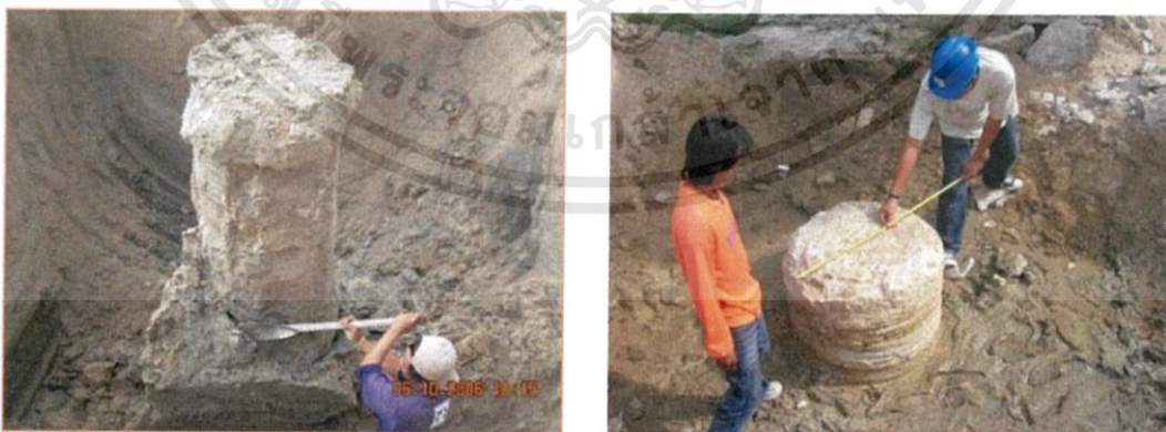
รูปที่ 2.44 การทดสอบหาขนาดความลึกและขนาดหัวเสาเข็มดินซีเมนต์[2]
