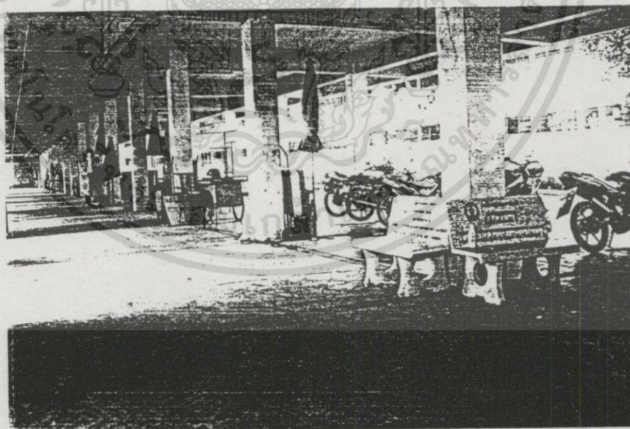
ภาพที่ 4.11 แสดงใต้ถุนอาคาร
