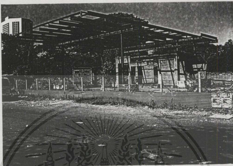
ภาพที่ 4.37 แสดง ปิมน้ำมันร้างบริเวณหลังแฟลต 18 วิทยุร่วมใช้มีว่สุมเป็นสถานที่เสพยาเสพติด
