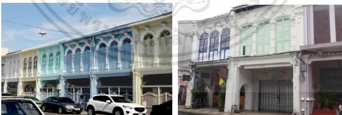
รูปที่ 2.25 ลักษณะอาคารตึกแถวย่านเมืองเก่าจังหวัดภูเก็ต
