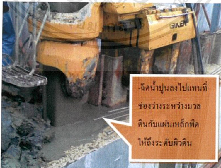
รูปที่ 2.10 แสดงการอัดฉีด Cement bentonite ลงไปแทนที่ช่องว่างในดิน (HIROSE,2559)
