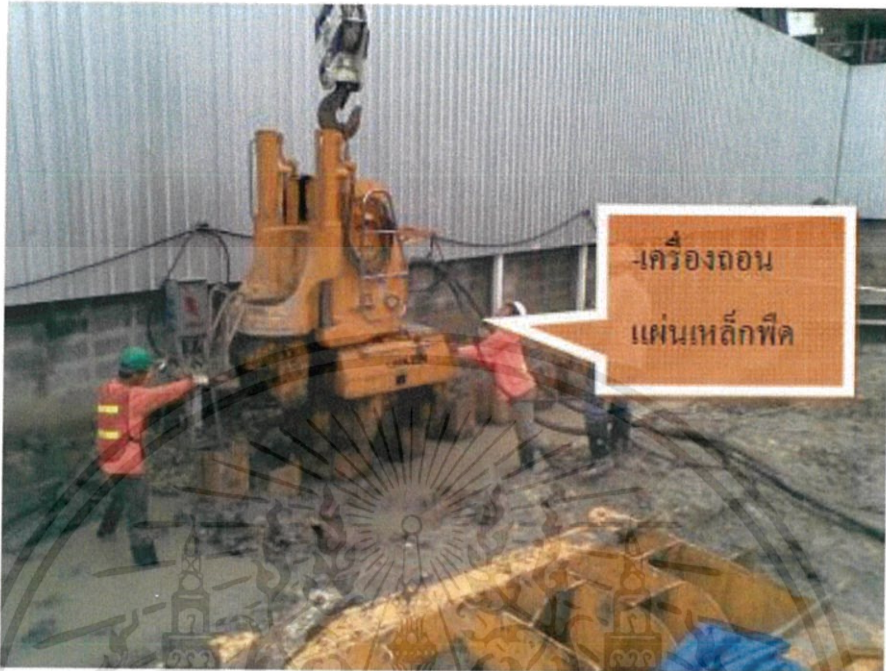
รูปที่ 2.9 แสดงเครื่องถอนซีทไฟล (HIROSE,2559)
