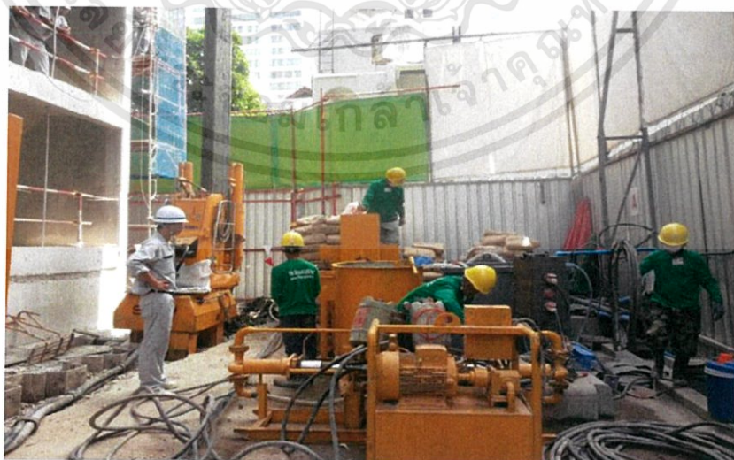
รูปที่ 2.6 แสดง Plant mixing (HIROSE,2559)
