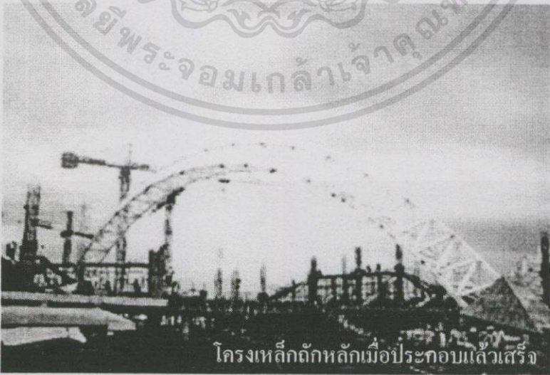
รูปที่ 3.13 แสดงการประกอบโครงเหล็กหลัก(Space Truss) โครงสร้างหลังคา
