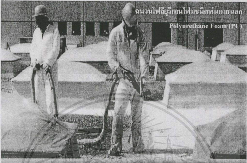
รูปที่ 3.28 แสดงฉนวนโพลียูรีเทนโฟมชนิดฉนวนบนหลังคา
