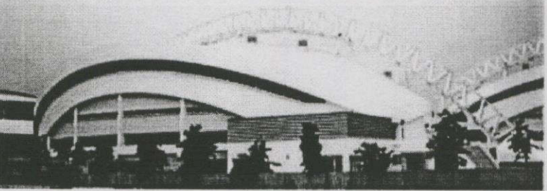
รูปที่ 3.15 แสดงโครงสร้างหลังคาเมื่อประกอบแล้วเสร็จ
