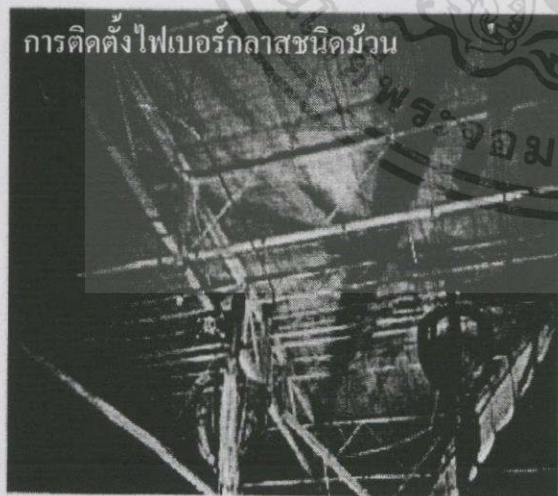
รูปที่ 3.24 แสดงการติดตั้งฉนวนชนิดแผ่นม้วนภายในใต้หลังคา
