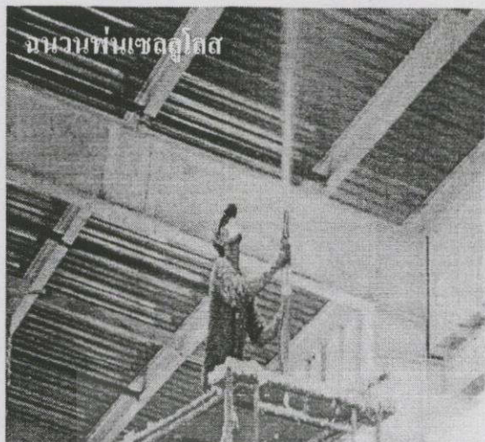
รูปที่ 3.23 แสดงการพ่นฉนวนเซลลูโลสใต้หลังคา
