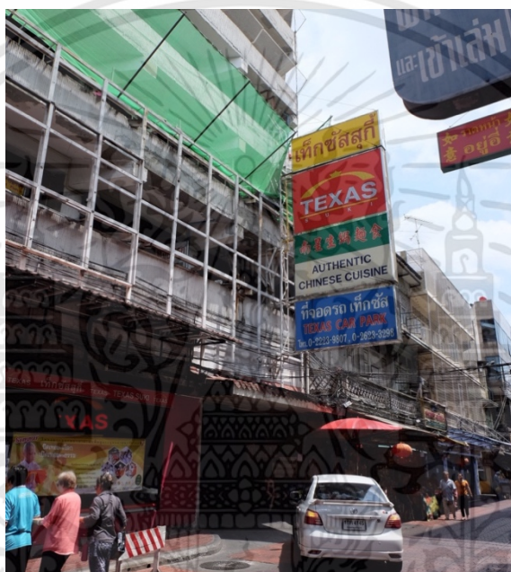
รูปที่ 2.1 : อาคารจอดรถเท็กซัส เยวาราช ที่มา:ผู้วิจัย
