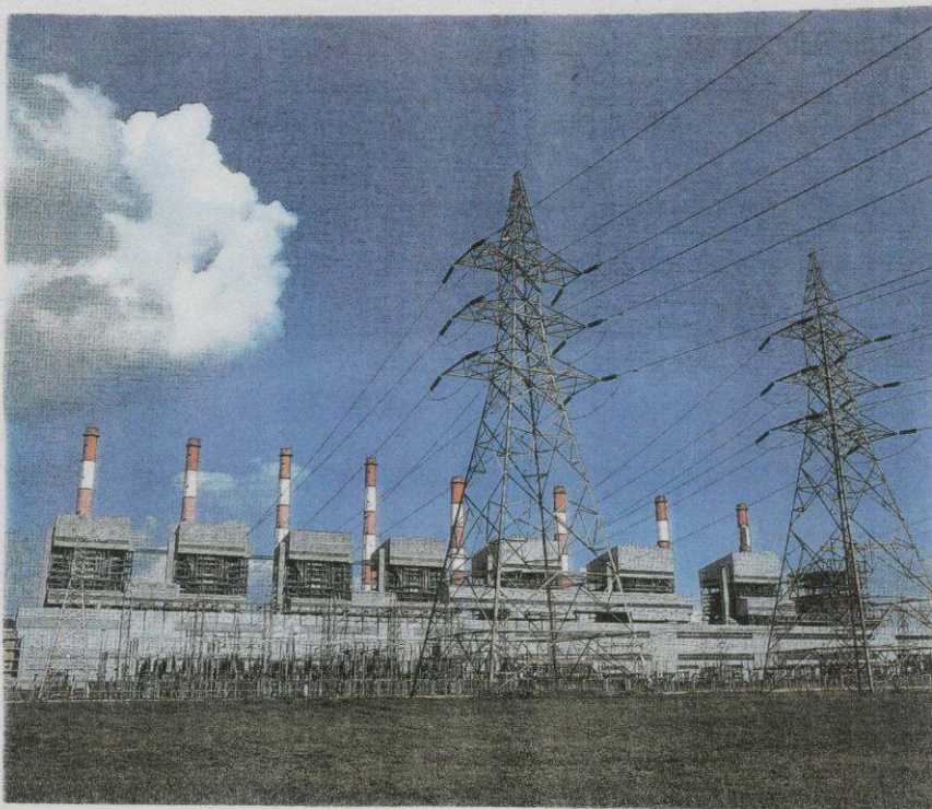
รูปที่ 2.4 แสดงสถานีไฟฟ้าอ้อยแม่เมาะ จังหวัดลำปาง
