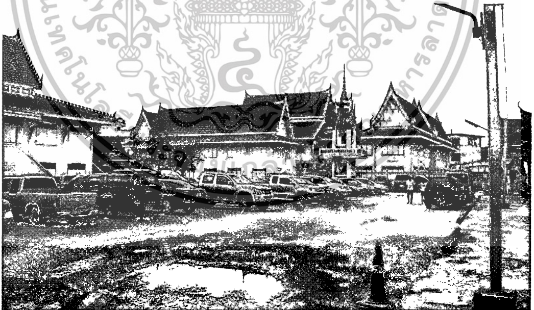
ภาพที่ 4.6 แสดงพื้นที่จอดรถภายในวัดบ่อ
