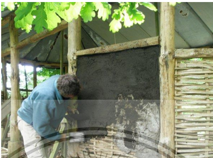
ภาพที่ 2.6 การปั้นดินกับโครงไม้
