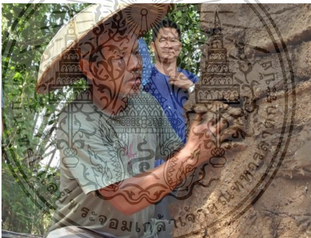
ภาพที่ 2.11 การฉาบผนังบ้านดิน
