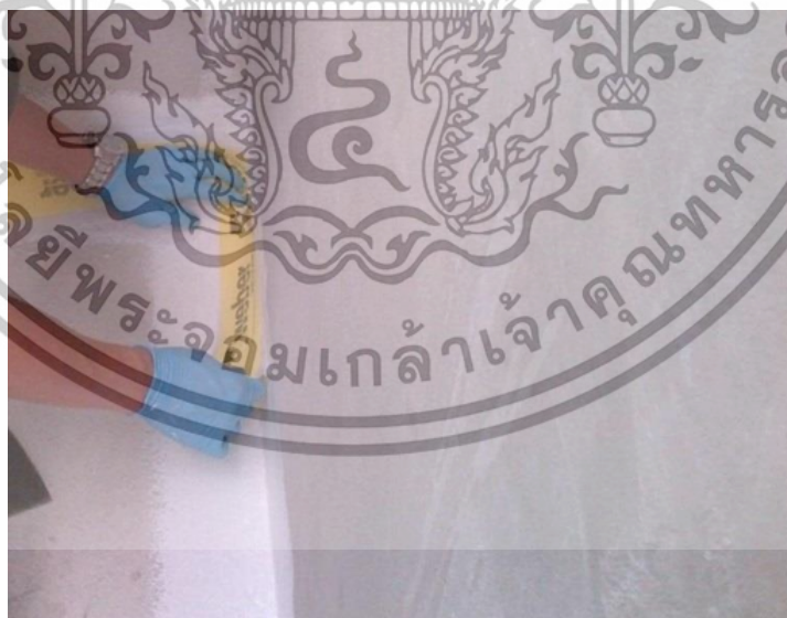
ภาพที่ 2.29 เทปกั้นซึมปิดรอยต่อพื้นและผนัง
