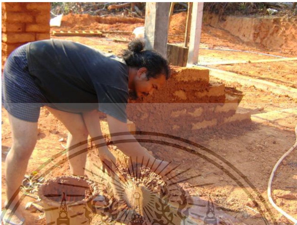
ภาพที่ 2.4 การก่ออิฐดินดิบ
