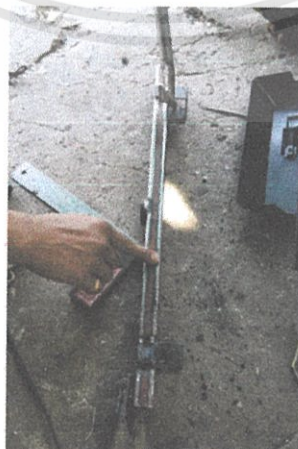
รูปที่ 3.24 ท่อเหล็กตัดแล้ว
