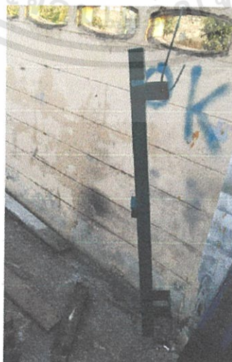
รูปที่ 3.27 แสดงการเชื่อมแท่งเหล็กกับเหล็กรูปตัวยู
