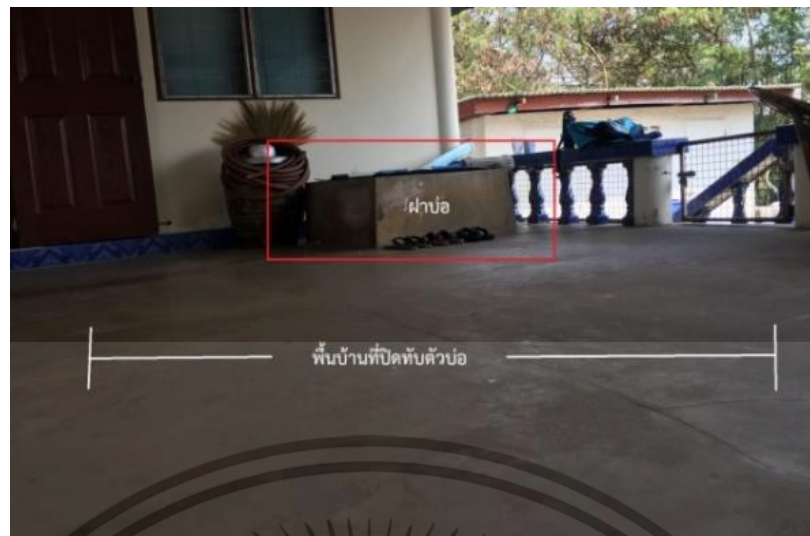
ภาพที่ 4.19 แสดงฝาบ่อและพื้นที่ที่ปิดทับบนบ่อ
