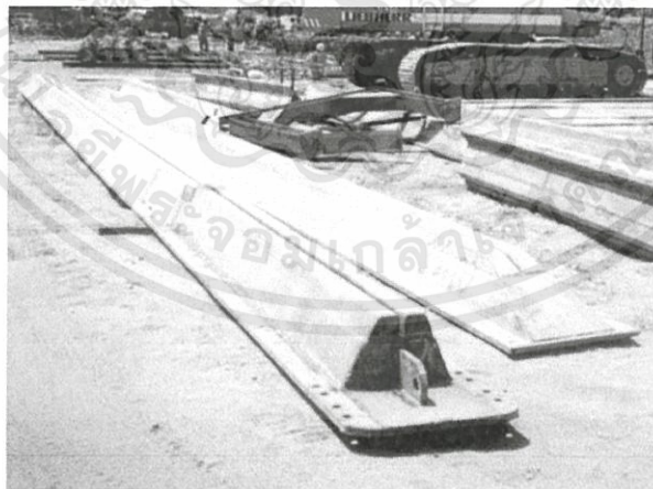
รูปที่ 3.5.ก Stop End Plates ก่อนการติดตั้ง
