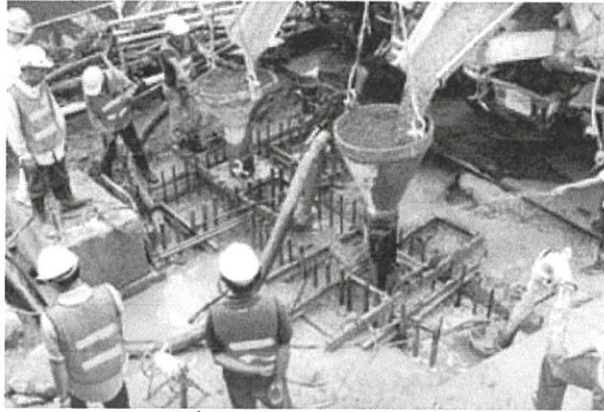
รูปที่ 5.7. การเทคอนกรีตท่อน
