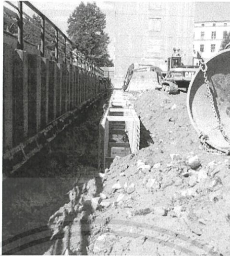
รูปที่ 5.3. การทำ Guide Wall
