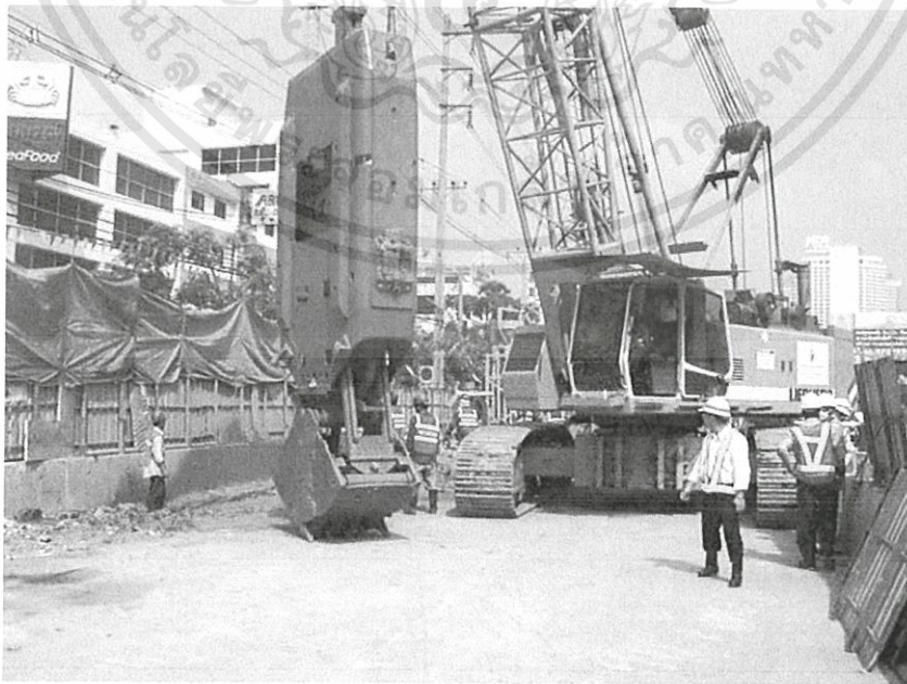
รูปที่ 5.1. หัวเจาะแบบ Cable Hang Grab
