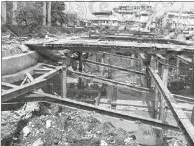
รูปที่ 2.8. การนำกองดิน (Berm) ช่วยในการค้ำยัน
