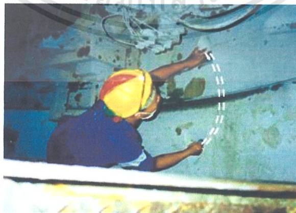
รูปที่ 4.6. คนงานตรวจสอบสลักเกลียวที่เชื่อมต่อระหว่างผนังอุโมงค์
