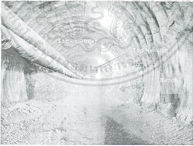
รูปที่ 4.14 ภาพตัวอย่างขณะก่อสร้างอุโมงค์(Good Rock Conditions)
