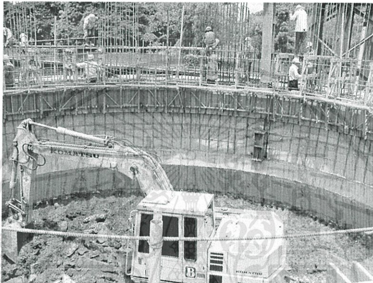
รูปที่ 5.12 การชูดคินภายในเคชองส์
