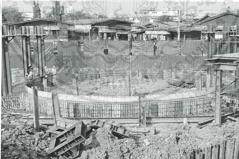
รูปที่ 5.5 การเทคอนกรีต Ring BEAM
