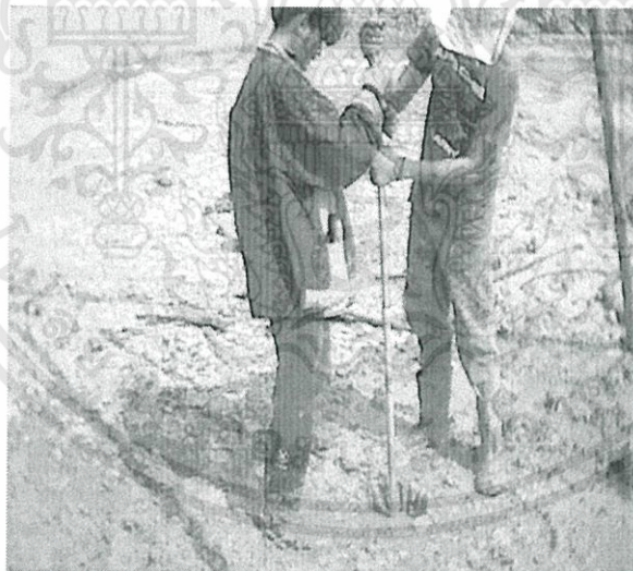
รูปที่ 5.35 การติดตั้ง Piezometer
