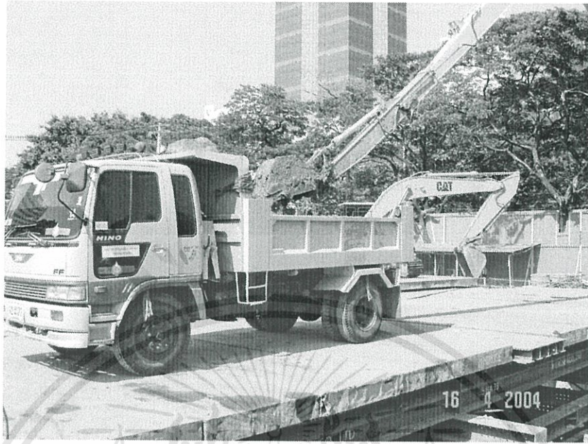
รูปที่ 5.19 Dump Truck 6 Well
