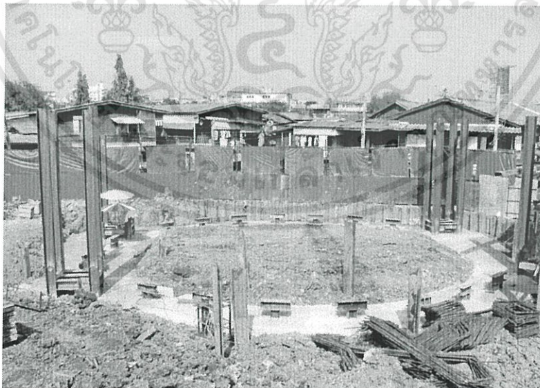
รูปที่ 5.3 การตอก H.BEAM ทั้ง 4 ตำแหน่ง เพื่อใช้ทำ Support ของ Jacking Frame และตอก H.BEAM โคยรอบเพื่อรับน้ำหนัก Ring BEAM
