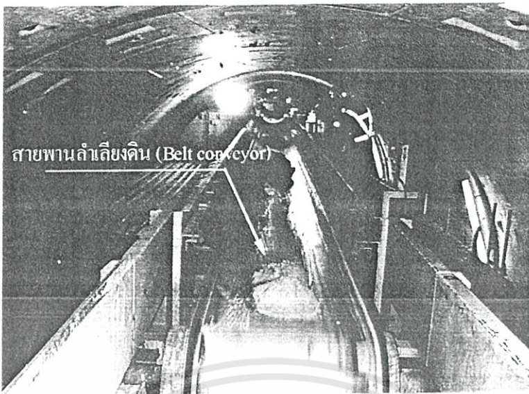
รูปที่ 3.1.2 สายพานลำเลียงดินที่ขุดออกจากเกลียวหมุนลำเลียงดิน
