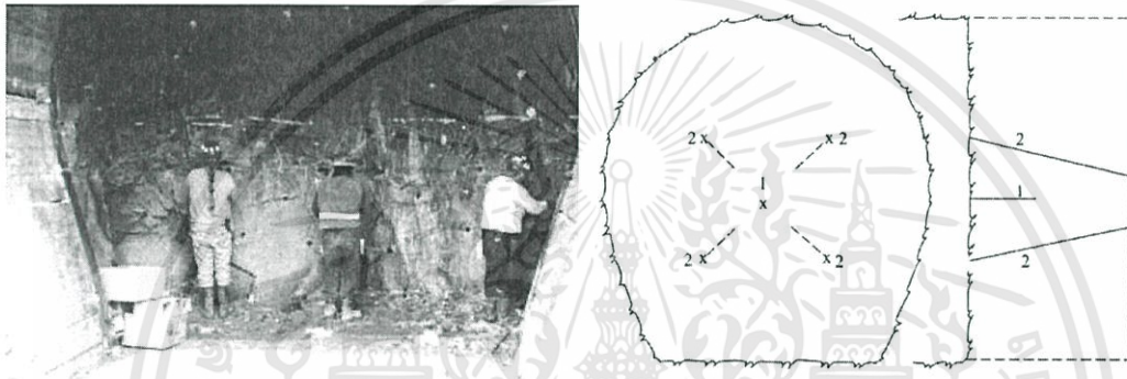
รูป 3.1 แสดงตัวอย่างการวางตำแหน่งของดินระเบิด (JOHN O.BICKEL, 1996)
