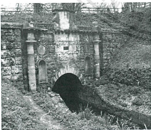
รูป 2.9 Sapperton Canal Tunnel
