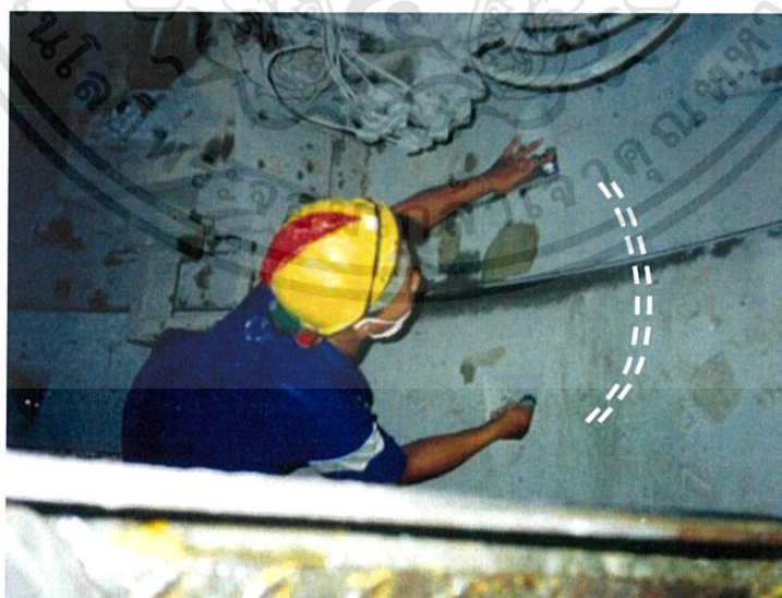
รูปที่ 2.22 คนงานตรวจสอบสลักเกลียวที่เชื่อมต่อระหว่างผนังอุโมงค์
