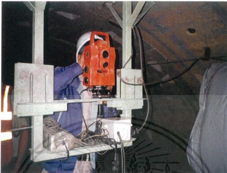
รูปที่ 2.28 กล้องเลเซอร์ติดตั้งที่วงรอบผนังอุโมงค์ด้านหลังหัวเจาะ
