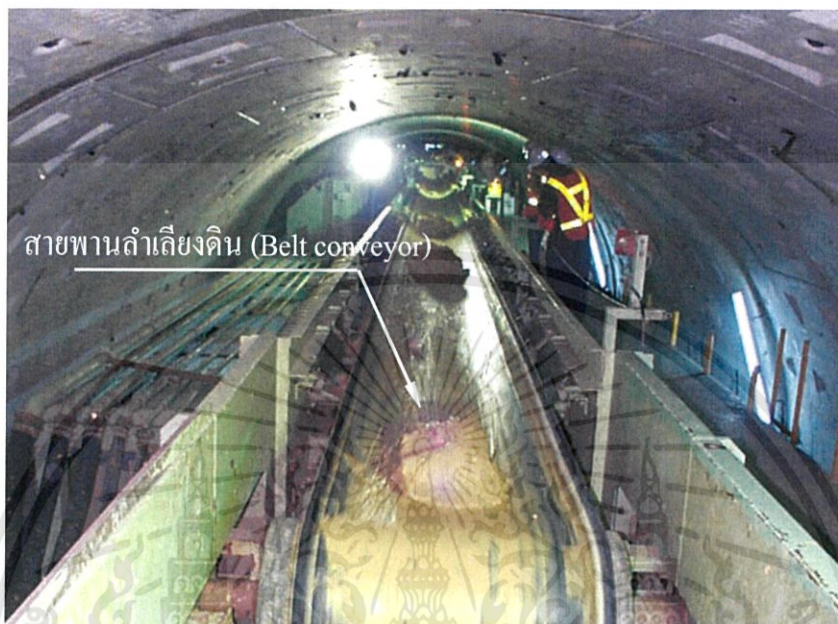
รูปที่ 2.8 สายพานลำเลียงดินที่ขุดออกจากเกลียวหมุนลำเลียงดิน
