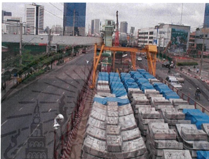
รูปที่ 2.17 การจัดเก็บผนังอุโมงค์บริเวณสถานีเทียนร่วมมิตรในโครงการรถไฟฟ้าใต้ดินสายเฉลิมรัชมงคล
