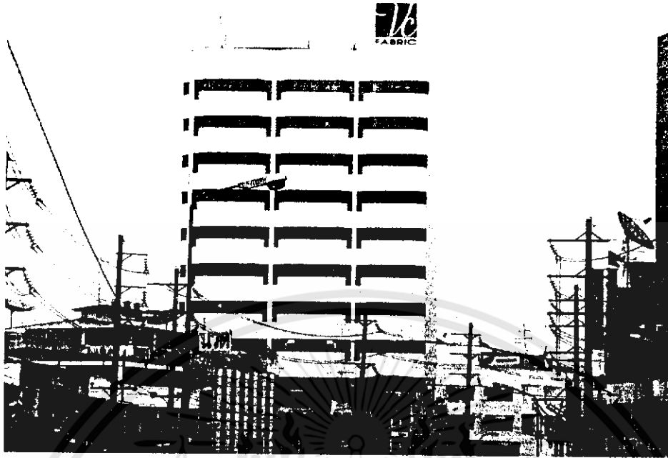
รูปที่ 7.5 อาคารวิจิตร
