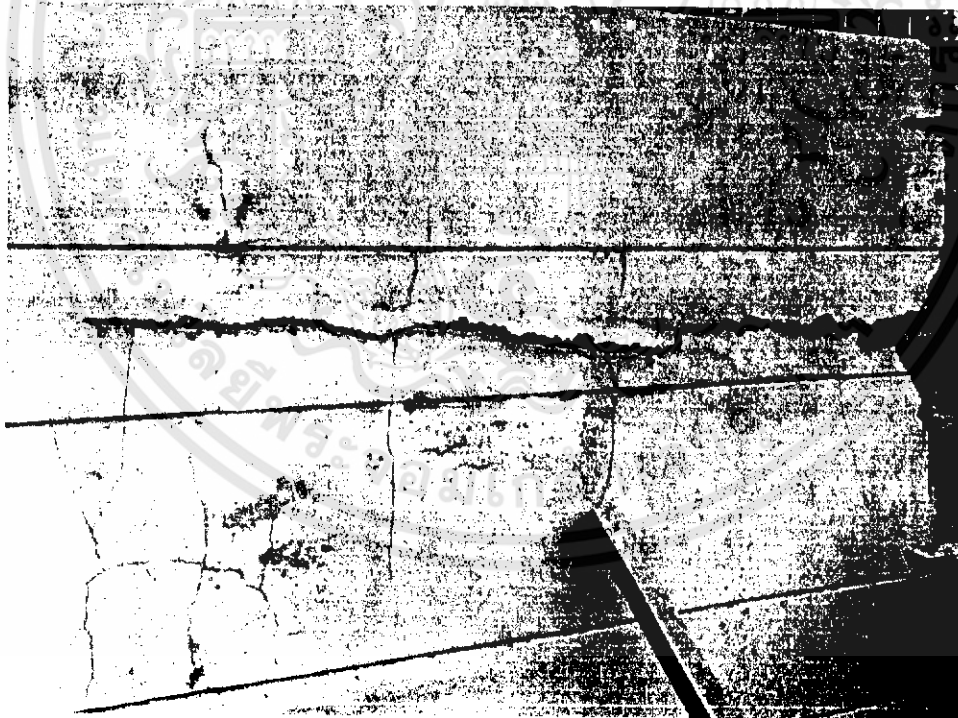
รูปที่ 7.6 รอยร้าวกำแพงกันดินหลังอาคารวิจิตร
