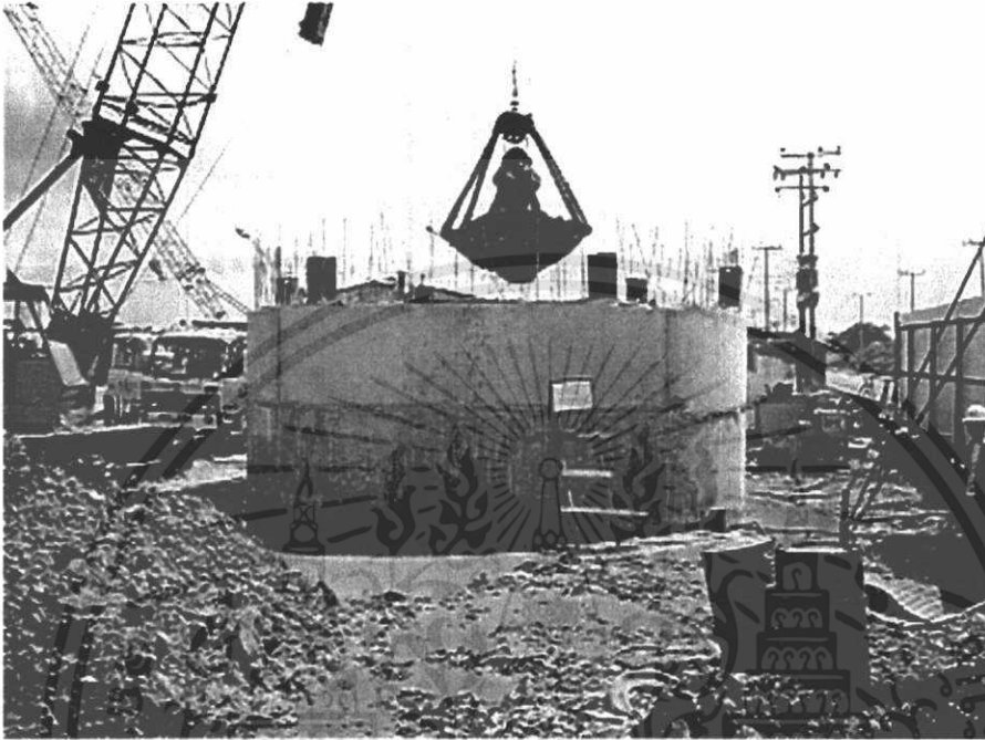
รูปภาพที่ 6. 18 แสดงการขุดดินออกจากบ่อ
