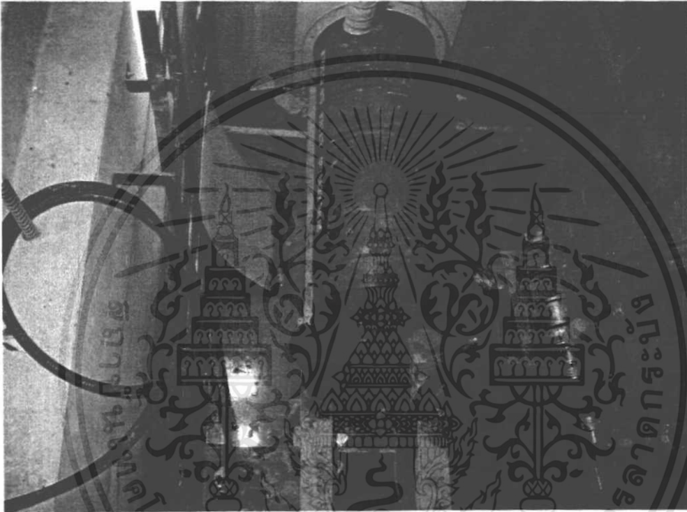
รูปภาพที่ 6.29 ภาพการเริ่มคันท่อหัวเจาะเข้า
