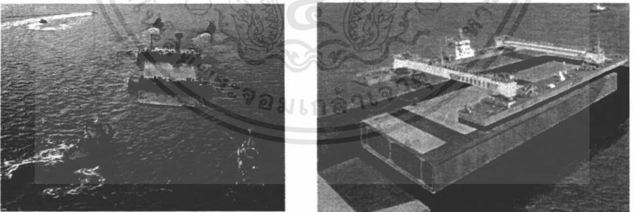
รูปภาพที่ 7.11 แสดงการลำเลียงชิ้นส่วนอุโมงค์ไปยังสถานที่ทำการก่อสร้าง
