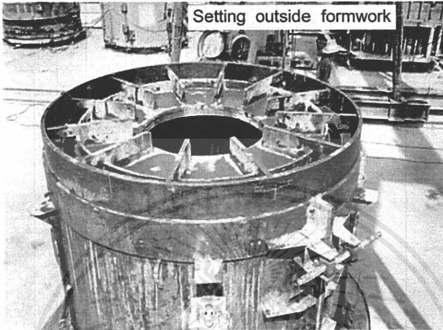
รูปภาพที่ 6. 5 แสดงแบบภายนอกที่นำมาประกบโครงเหล็ก
