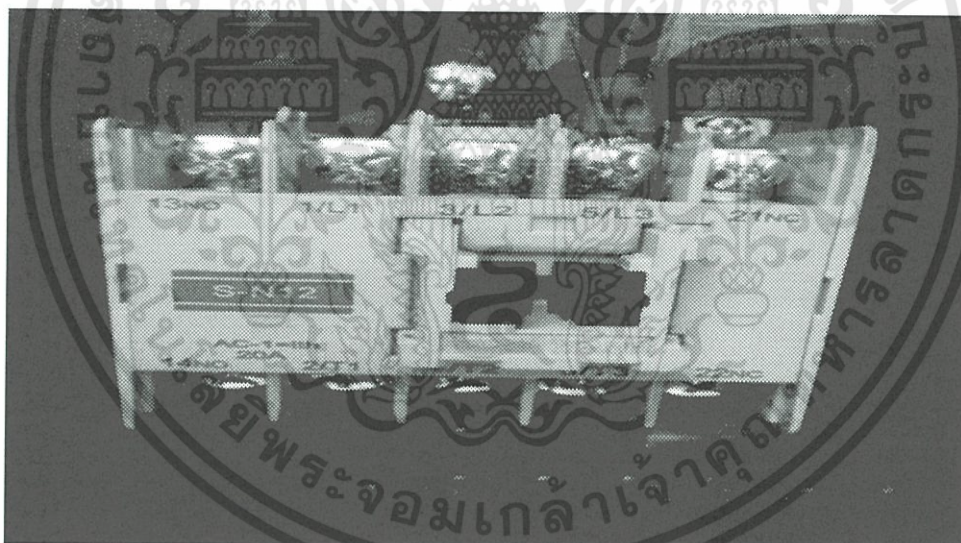
ภาพที่ 3.9 แมกเนติกคอนแทคเตอร์
