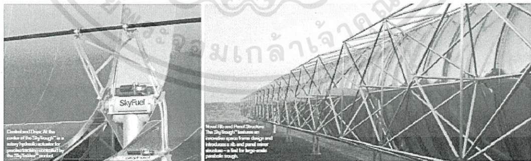
รูปที่ 2.16 แสดงโครงสร้างรับวัสดุสะท้อนแสงโค้งและท่อดูดซับ
