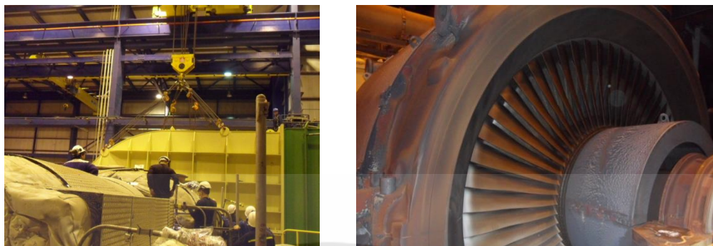
รูปที่ 2.19 การยก Casing ของ LP Last-Stage Blades
