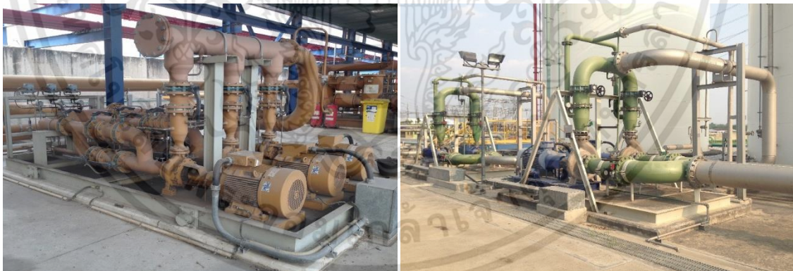
รูปที่ 3.4 Suction & Discharge Valve ของ Fuel Oil และ NOx Water Forwarding Pump
