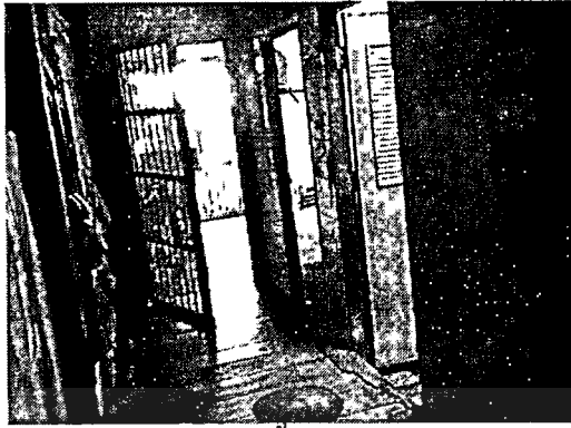
บริเวณห้องนำ และห้องส้วม
