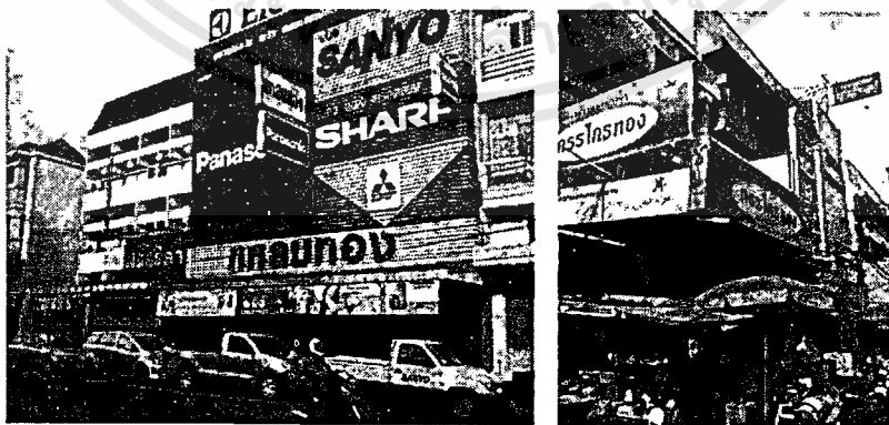
ภาพที่ 1.4 แสดงปัญหาเรื่องการต่อเติมและตัดแปลงอาคารตึกแถว
