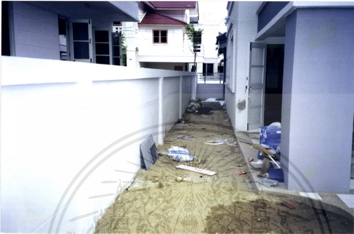
ภาพที่ 10 แสดงพื้นที่บริเวณข้างบ้านบ้านด้านทิศตะวันออกก่อนการปรับปรุง
