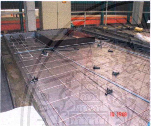
ภาพที่ 2.8 ขั้นตอนการติดตั้งเหล็กเสริมต่างๆ
