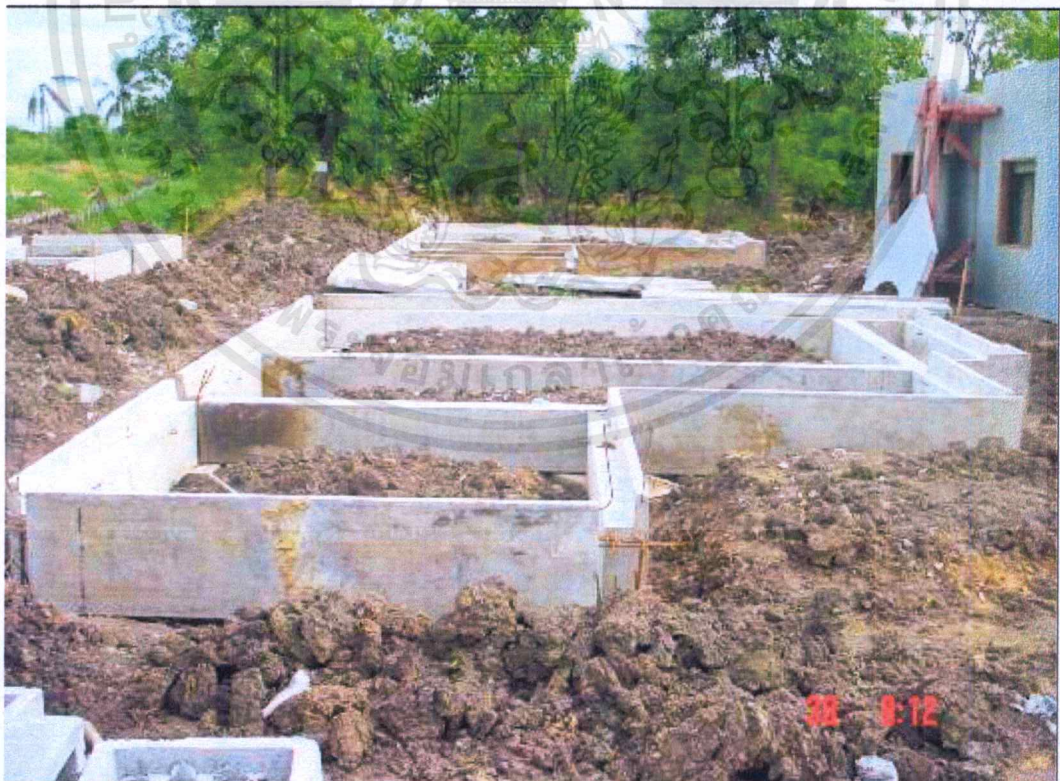
ภาพที่ 2.22 แสดงลำดับการติดตั้งคานชั้น 1 (หลังติดตั้งเสร็จ)
