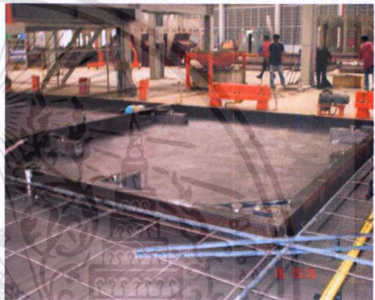
ภาพที่ 2.8 ขั้นตอนการติดตั้งเหล็กเสริมต่างๆ
