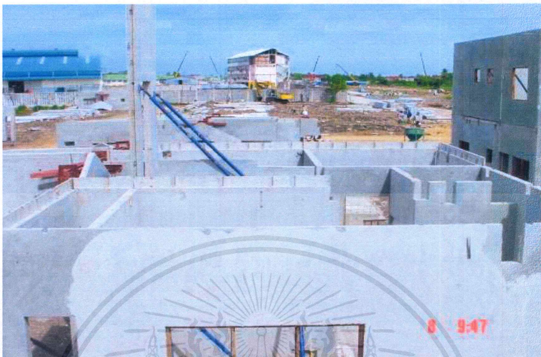
ภาพที่ 2.29 แสดงลำดับการติดตั้งผนังชั้น 1 (หลังติดตั้งเสร็จ)
