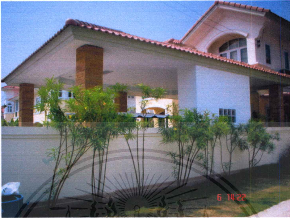
ภาพที่ 4.9 ต่อเติมที่จอดรถ จากโครงการที่สำรวจ
