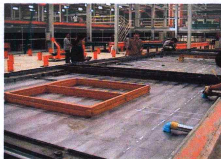
ภาพที่ 2.6 ขั้นตอนการติดตั้งวงกบประตู-หน้าต่าง
