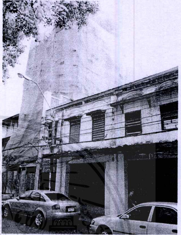
รูปที่ 4.6 อาคารใหม่ที่กำลังก่อสร้าง
