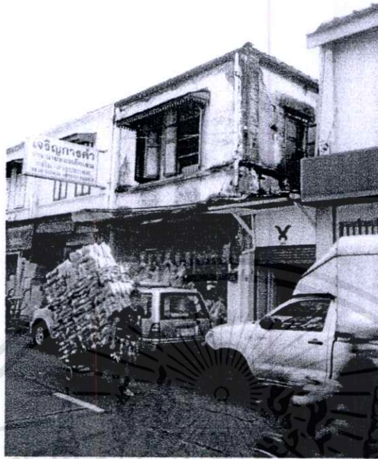
รูปที่ 5.7 อาคารที่เก่าทรุดโทรมไม่สามารถอนุรักษ์ฟื้นฟูให้กลับมาอยู่ในสภาพเดิมได้
