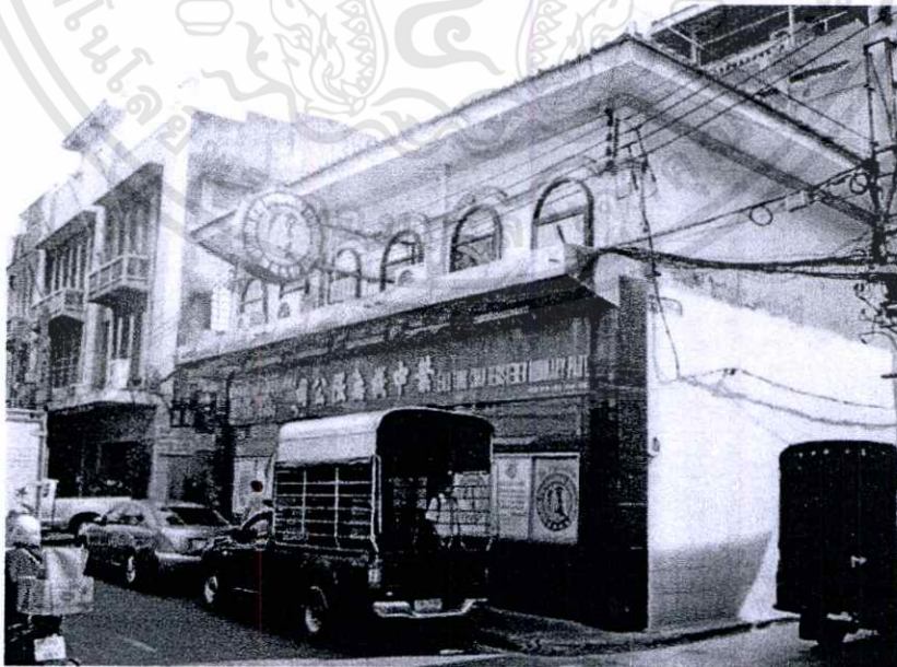
รูปที่ 5.5 อาคารที่มีการต่อเติมอย่างไม่เหมาะสม
