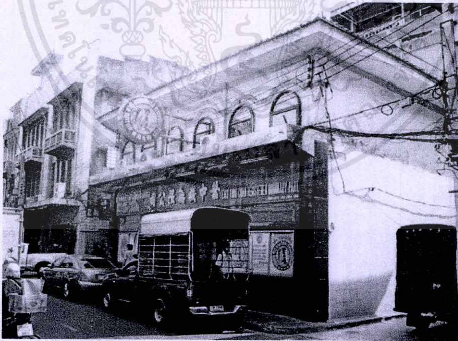
รูปที่ 4.7 อาคารที่ถูกดัดแปลงโดยไม่ได้คำนึงถึงรูปแบบสถาปัตยกรรมแบบเดิม
