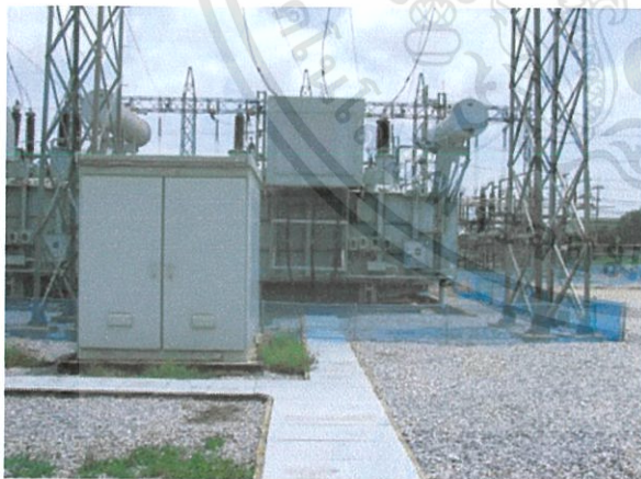
รูปที่ 2 ตำแหน่งการติดตั้ง NGR ภายในสถานีไฟฟ้า
