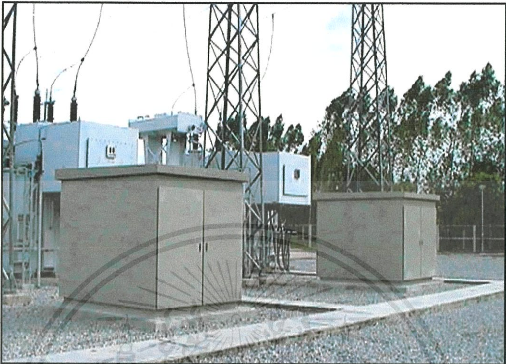
รูปที่ 2.26 ตำแหน่งตู้ NGR ที่ติดตั้งภายในสถานีไฟฟ้า
