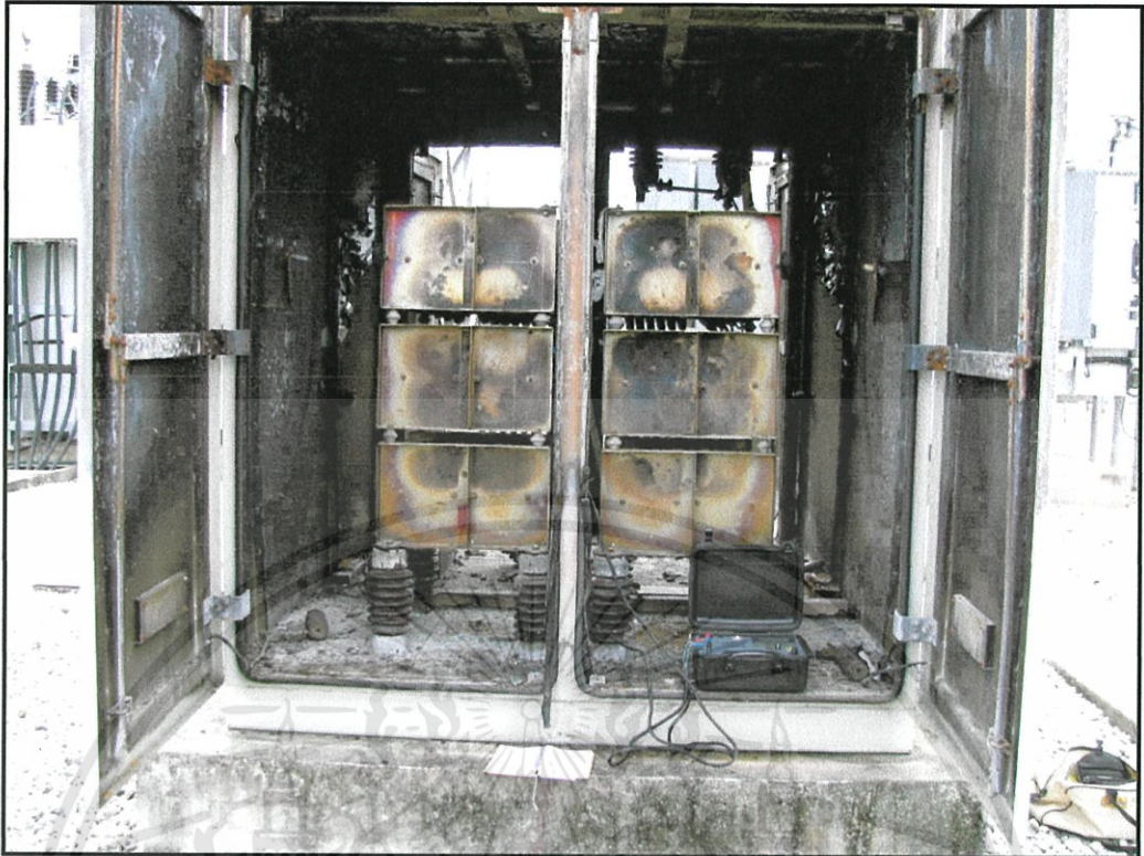
รูปที่ 3.16 การวัดค่าความต้านทานขดลวดของ NGR ชุดที่ได้รับความเสียหาย
