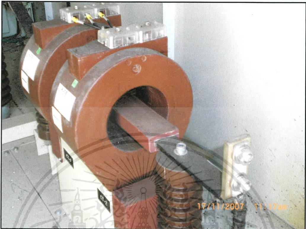
รูปที่ 3.9 สภาพปกติของหม้อแปลงกระแสที่ติดตั้งภายในตู้ NGR
