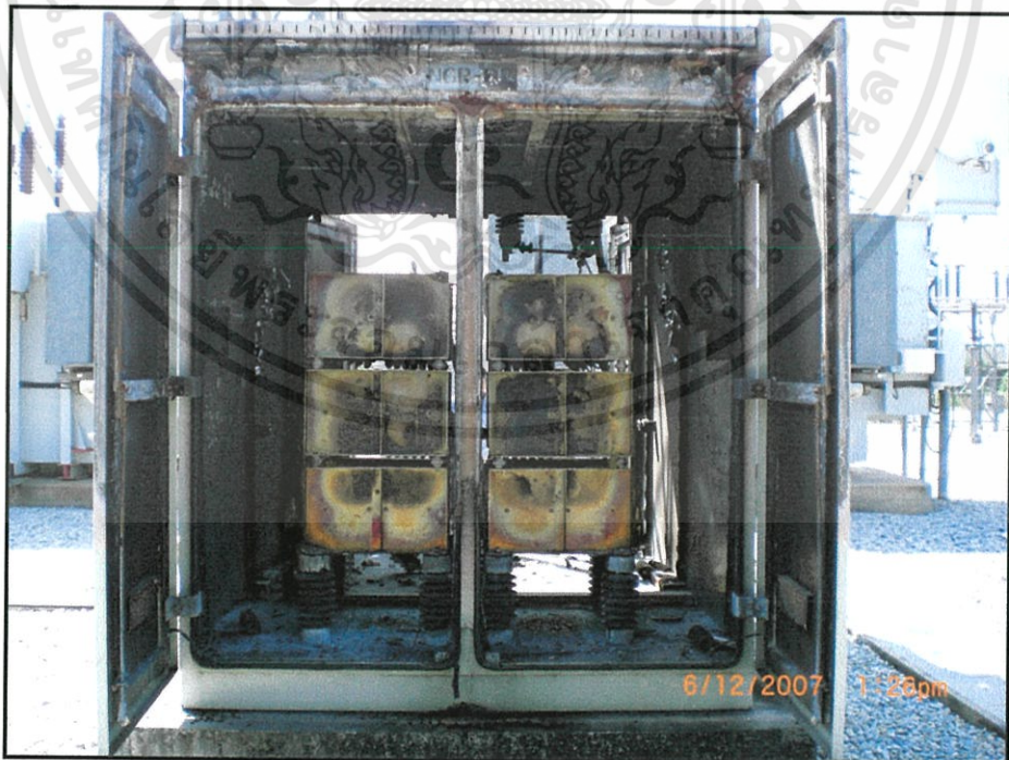
รูปที่ 3.4 สภาพภายในตู้ NGR ภายหลังได้รับความเสียหาย
