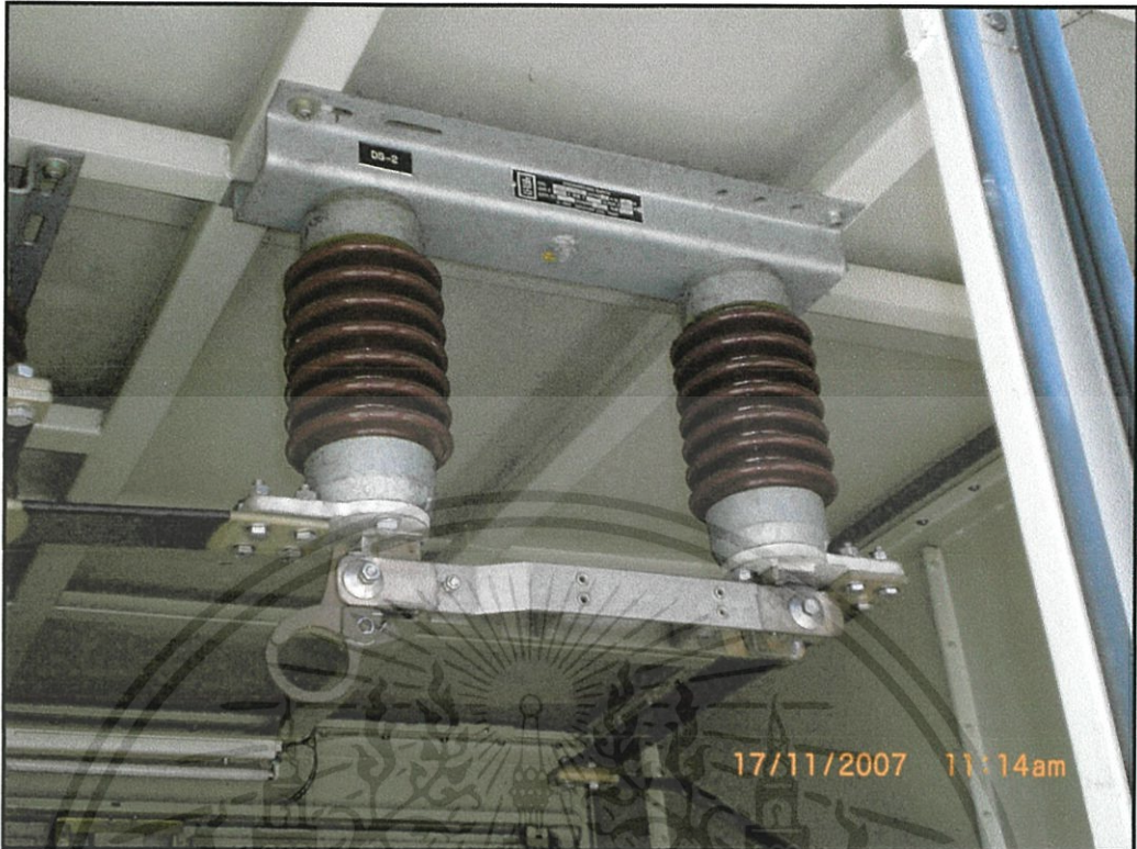
รูปที่ 3.7 สภาพปกติลูกถ้วยที่ติดตั้งภายในตู้ NGR
