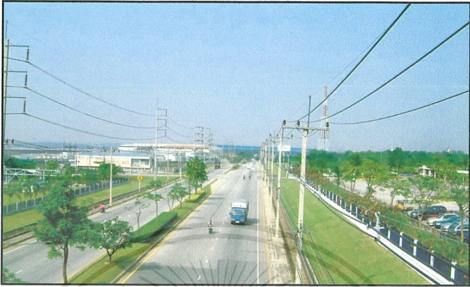
รูปที่ 2.4 โครงสร้างระบบจำหน่ายของการไฟฟ้าส่วนภูมิภาค
